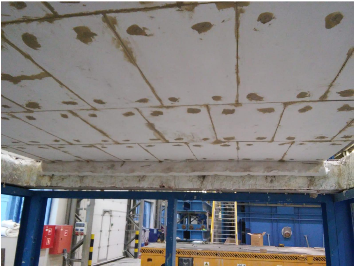
Rysunek 1. Płyty Novoper 60mm zamontowane na płycie żelbetowej 3x4.5m.
